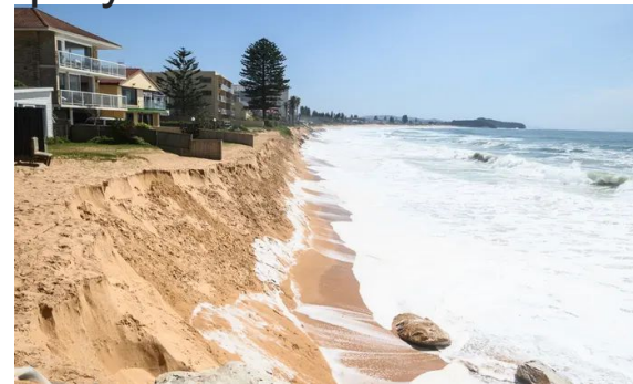
Erosión de la playa
